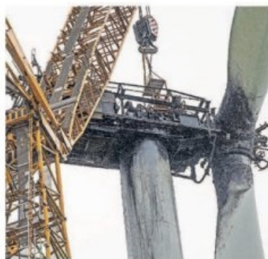
In luftiger Höhe werden die Demontagearbeiten am abgebrannten Windradtraktor bei Losheim erledigt. FOTO: ROLF RUPPENTHAL
