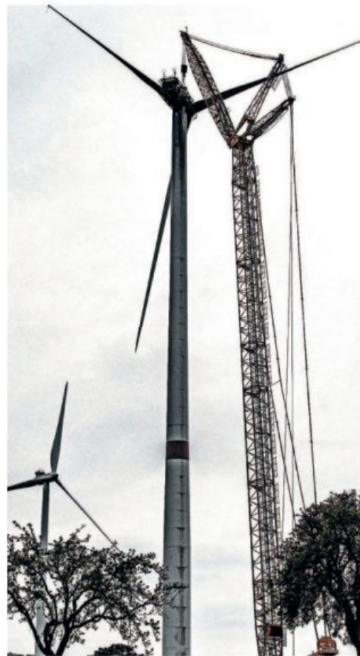
Am Samstag sollen nun der Rotor, die zerstörte Gondel und die Turmteile mit einem Spezialkran zu Boden gelassen werden. FOTO: ROLF RUPPENTHAL
