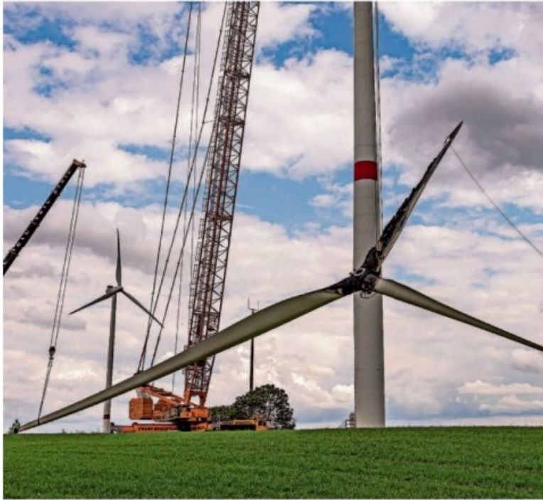
Demontage des abgebrannten Windrades zwischen Rissenthal und Losheim neben dem Markushof: Am Samstag wurde: Im Verlaufe des Samstags wurde aufwändig der mächtige Rotor abgebaut.
