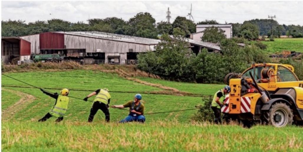
Auch rohe Körperkraft ist bei dem Abbau des Windrades gefordert.
