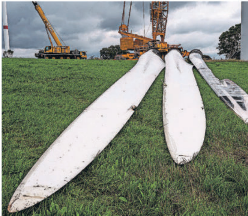
Der windige Dienstag wurde dazu genutzt, den Rotor auseinanderzubauen. Die drei Blätter werden vor Ort zerkleinert und später recycelt. FOTO: ROLF RUPPENTHAL
