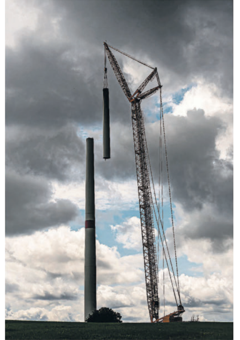
Nach dem Abbau der Gondel musste das oberste Turmelement schnell entfernt werden, da die Stabilität des Turms nicht mehr gegeben war. FOTO: ROLF RUPPENTHAL
