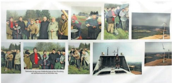
Historische Aufnahmen vom Bau des ersten Windrades im Jahr 1993 stellte der Fotoclub Tele Freisen aus.
